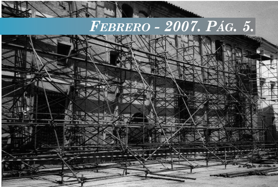
Colocación de los andamios protectores. Foto: Archivo Sabinius Sabinianus.
